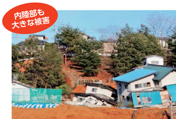
家屋被害の状況 (福島市伏拝地区)
