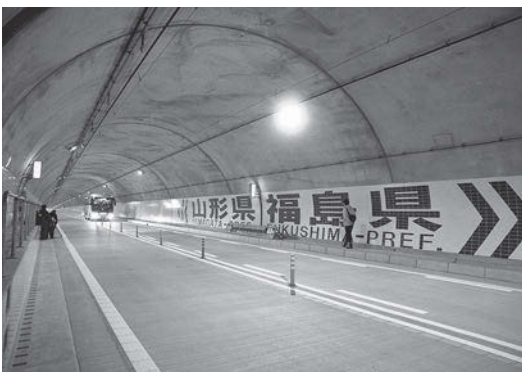
開通前の栗子トンネルの内部（県境にて） 提供／国土交通省東北地方整備局福島河川国道事務所
