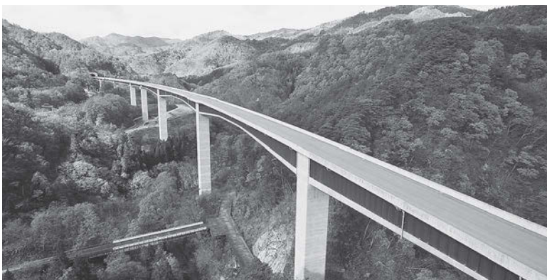
利便性はもちろんのこと眺望が抜群の中野大橋 提供／国土交通省東北地方整備局福島河川国道事務所
