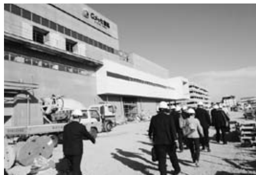
▲建設中のGメッセ群馬を視察
