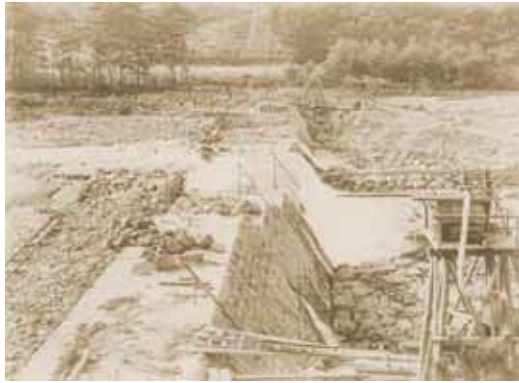
建設当時の地蔵原堰堤
