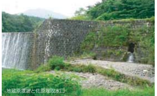
地蔵原堰堤と佐原堰取水口
