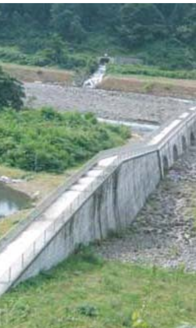
荒川遊砂地大暗渠砂防堰堤
