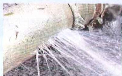
ビル内店舗のガスマーター交換時、誤って給水管を破損し階下の店舗に漏水。
