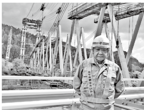
第6只見川橋りょう(金山町)の現場に立つ加藤さん。非常に難しい工事だが、地域住民の再開通への熱い思いが使命感をかきたてる。
